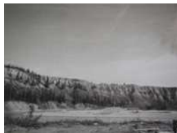
18022JG BIG HORN DAM.jpg
